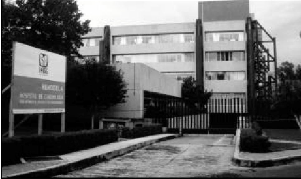
Figura 1-1 Hospital de Cardiografía del Instituto Mexicano del Seguro Social que fue reforzado usando marcos como contrafuertes, luego del Sismo de 1985.
