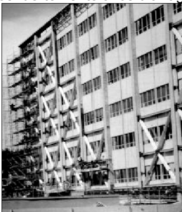
Figura 1-1 Refuerzos con diagonales
