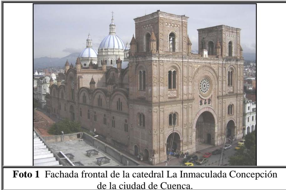
La estructura actualmente tiene las siguientes características geométricas: largo 105.31m, ancho 43.20m, área de emplazamiento 4550m<sup>2</sup>, la altura actual de las torres es de 40.00m y la altura total de la estructura en la cúpula central es de 53,20m.
