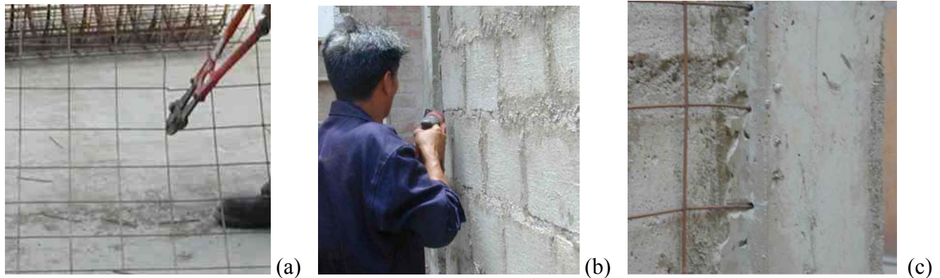
Figura 6. Colocación de la malla en el muro M2
