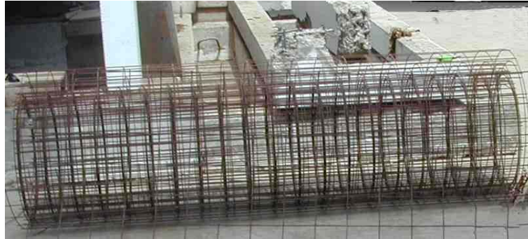
Figura 2. Malla electrosoldada empleada
