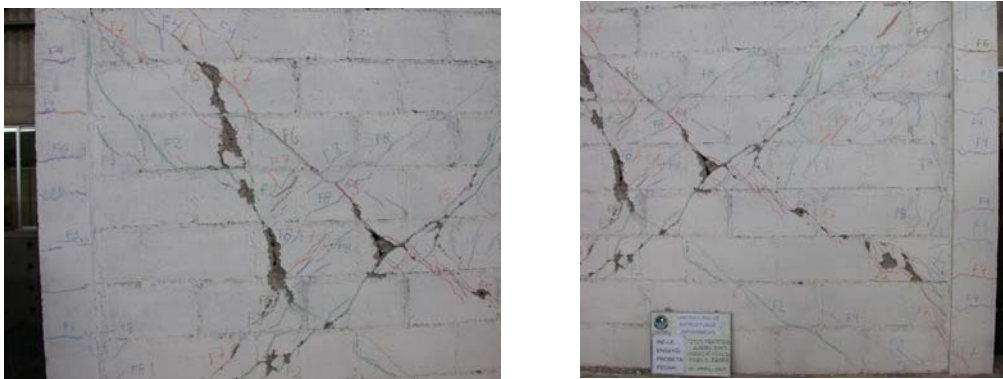
Figura 13. Detalles del estado de fisuración del muro M1 al final del ensayo.
