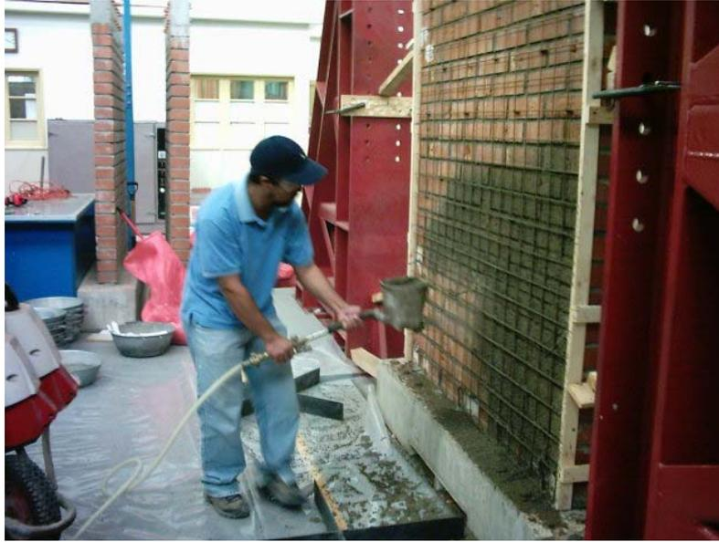
Figura 3.4: Aplicación de mortero proyectado
