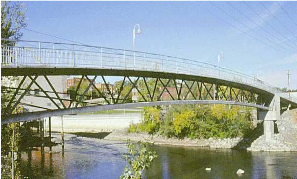
Figura 4.1 Pasarela Peatonal Sherbrooke
