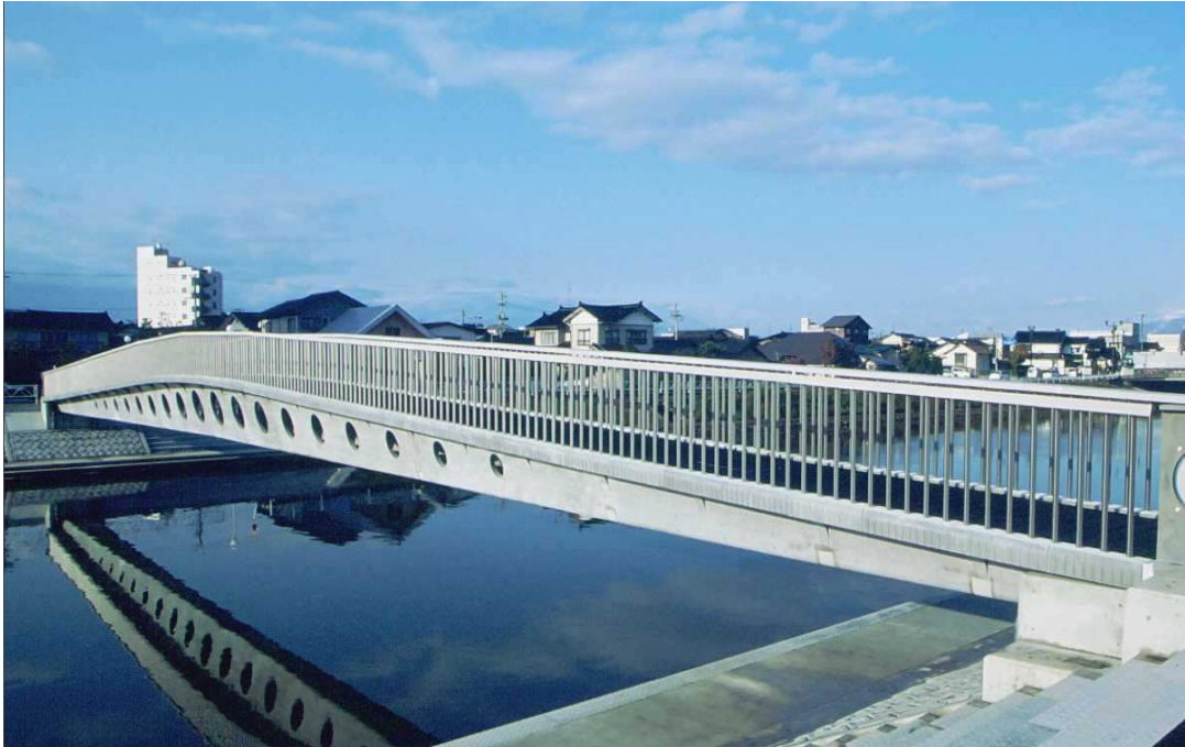
Figura 4.4 Puente Sakata Mirai
