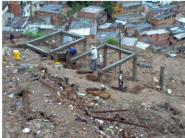
Figura No. 4. Pedestales de fundación
