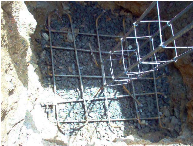
Figura No. 3. Zapata de fundación
