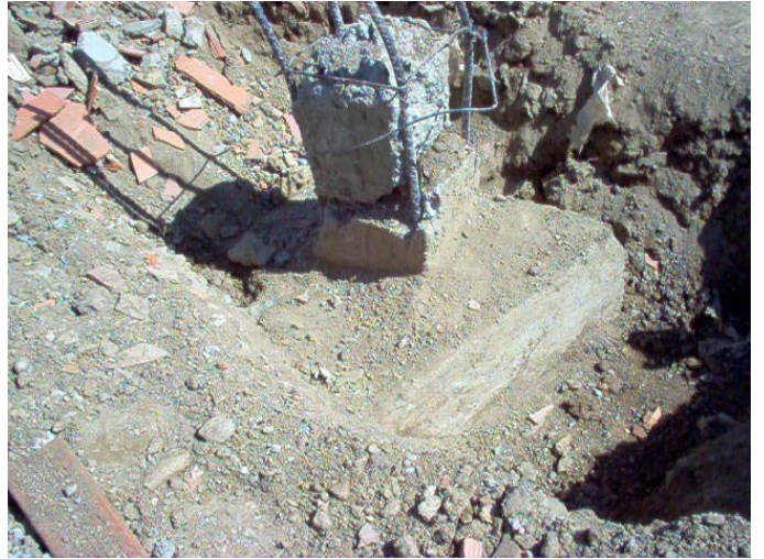
Figura 15 – Columna superior M2 excavada
