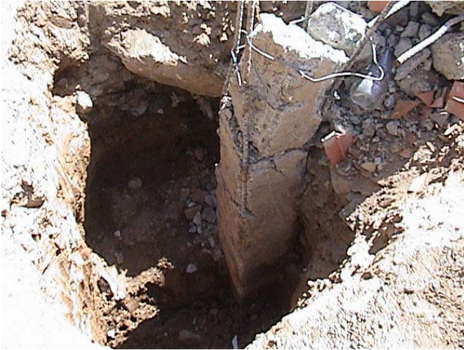
Figura 14 – Columna superior M1 excavada
