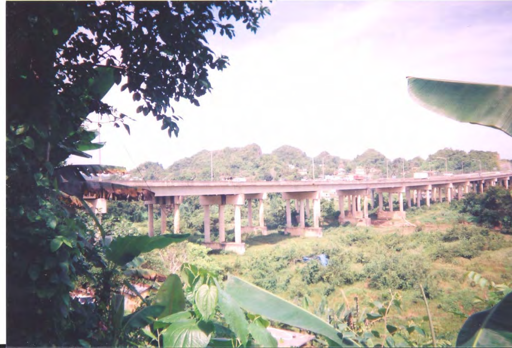
Figura 3.3 Vista hacia el suroeste del Puente sobre el Río Indio
